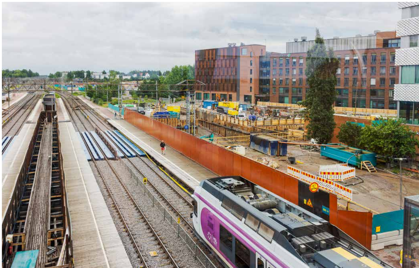
Junat kulkevat normaalisti Tikkurilassa, vaikka aivan radan vieressä ja sen alla rakennetaan ratikalle tulevaa alitustunnelia.
