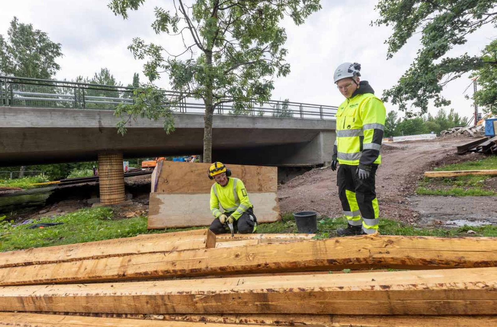
Sami Lintunen (vas.) puhdistaa pelkkapuita nauloista uusiokäyttöä varten Destian osaprojektipäällikkö Jussi Tiaisen seurattessa työtä. Taustalla näkyy rakenteilla oleva Kylmäojan uusi silta, jolle mahtuvat ratikat, autot ja kevyt liikenne.
