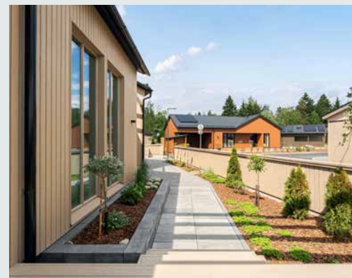
Saikan asuinalueen rakentamisessa on huomioitu ilmastoviisaus.
